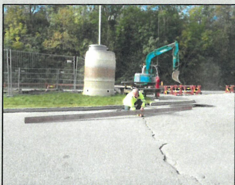
Det settes krav til maksimum setning på grøfter som er 3 år gamle
