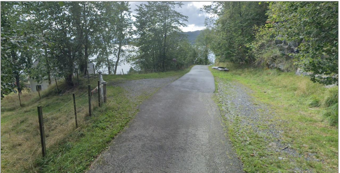
Figur 22: Eksisterande trafikklorre langs Skorpevegen nord-vest i planområdet, sett mot sør. Kjelde: www.googlemaps.no
